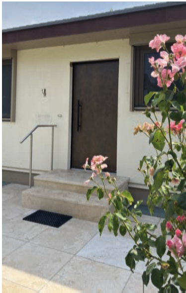
Eingang Neue Außenfliesen, eine aufgewertete Treppe und eine Tür in Cortens-tahloptik verleihen dem Eingangsbe-reich einen modernen Charakter.
