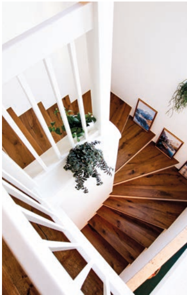
Treppe Die bestehende Treppe wurde mit hochwertigem Parkett aufbereitet und fügt sich nun harmonisch in das renovierte Gesamtbild ein.
