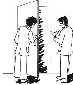
Bitte kontrollieren Sie sofort nach erfolgter Montage Ihre Haustür. Ist diese beschädigungsfrei montiert, sind die Griffgarnituren sicher befestigt, funktioniert die Haustür einwandfrei (leichtgängig), Verriegelung prüfen, ggf. E-Öffner und Kältefeind testen usw. Auf dem Bauabnahmeprotokoll bestätigen Sie den Erhalt und die Montage Ihrer UNILUX Haustür, mit der wir Ihnen für die nächsten Jahrzehnte viel Freude wünschen.
